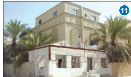
المبنى أثناء تركيب البلاطات
