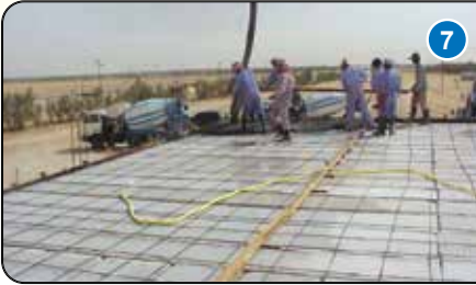
وضع شبكة حديد تسليح قطر 8 مم (اختياري)
