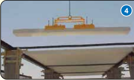
تركيب البلاطات بشكل متجاور
