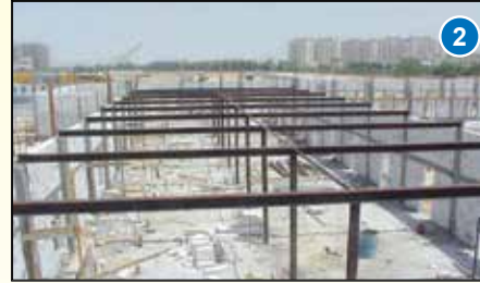
هيكل حديدي قبل التركيب للمباني الواسعة
